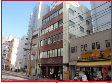
當木工事 本社
